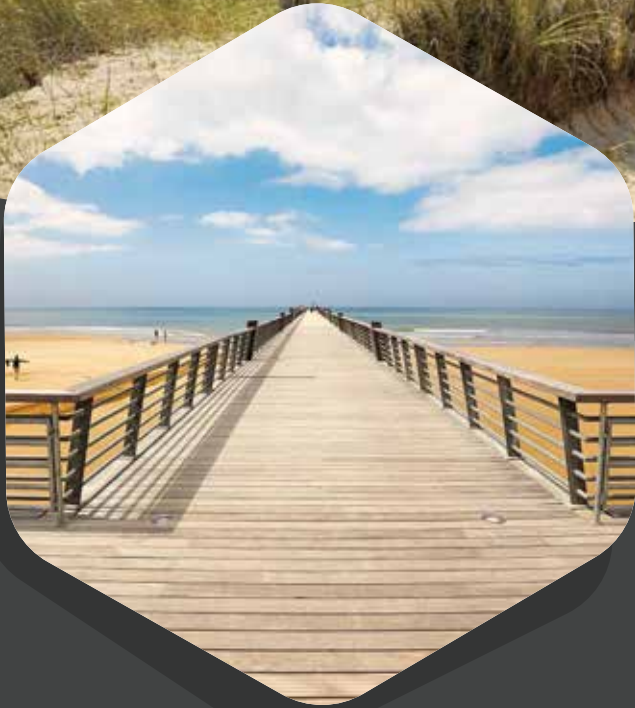
estacade de Saint-Jean-de-Monts
