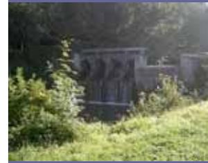
sont un magnifique ouvrage datant du XVIIIème siècle entièrement en blocs de pierre de taille : elles permettaient alors de réguler le débit de la rivière locale en stockant une masse d'eau dans une zone appelé le bief. L'ouverture et la fermeture des vannes permettaient de libérer et de retenir l'eau ainsi stockée qui permettait le fonctionnement des scieries de marbre.
