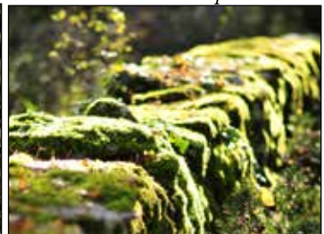
Muret de pierre sèche
