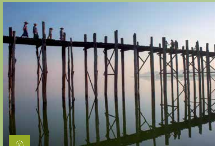
Pont en teck de U Bein sur le lac Taungthaman à Amarapura dans la banlieue de Mandalay. C'est le plus long pont en teck du monde.
